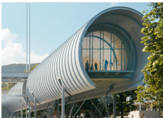
Enveloppe métallique du projet Portail de la Science – CERN, Genève .
