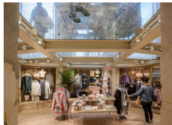
Plancher en verre sur structure métallique : magasin Etam , boulevard Haussmann, Paris.
